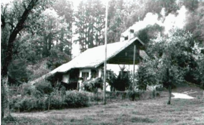
4 Ecoteaux, La Cergne: Zu diesem Hof gehörten neben dem Göpel ein Ofenhaus und ein Kornspeicher. Der Betrieb war also ganz auf die Getreidewirtschaft ausgerichtet. Der Göpel befand sich unter dem tief herabgezogenen Pultdach, das auf der linken Bildhälfte zu sehen ist. Aufnahme 1990.
