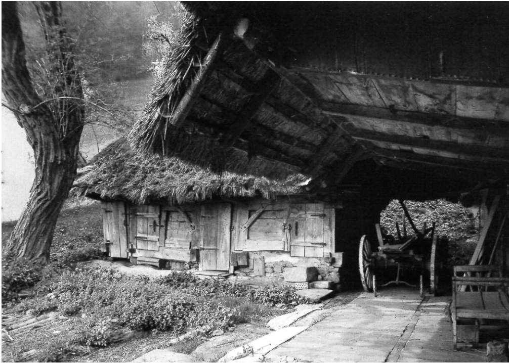
6 Kirchleerau AG: Schweinestall bei einem Strohdachhaus. Das Gebäude ist ebenso wie der Altenburger Stall aus Resthölzern und zweitverwendetem Material zusammengezimmert. Aufnahme 1944.
