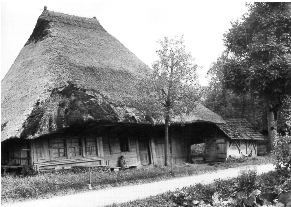
7 Gontenschwil AG: Bauernhaus mit freistehendem Schweinestall. Das Gebäude wurde aufwendig als Bohlen-Ständerbau mit Kopfbändern errichtet und unterscheidet sich optisch stark vom Schweinestall aus Altenburg. Aufnahme 1913.
