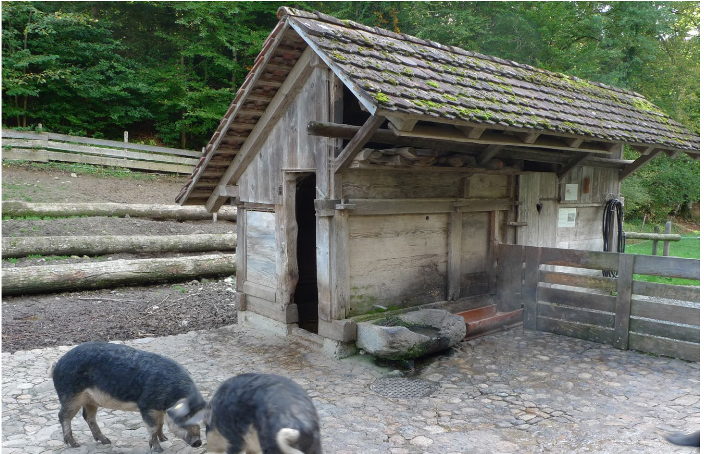
14 Freilichtmuseum der Schweiz, Schweineestall aus Altenburg/Brugg: Die nun nach Süden ausgerichtete Längsseite weist mehrere Büge auf, die das kurze Vordach stützen. Blick nach Nordwesten. Aufnahme 2013.
