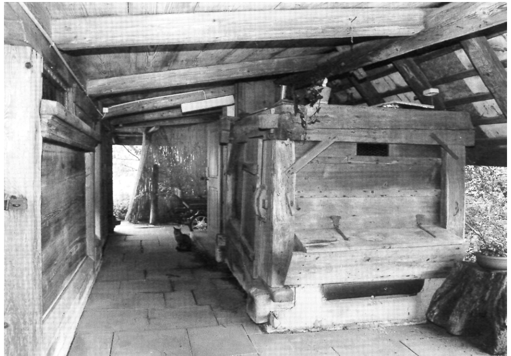
8 Kölliken AG: Schweinestall in Bohlen-Ständerbauweise, der unter dem Dachschermen eines Bauernhauses von 1745 steht. Aufnahme 1999.
