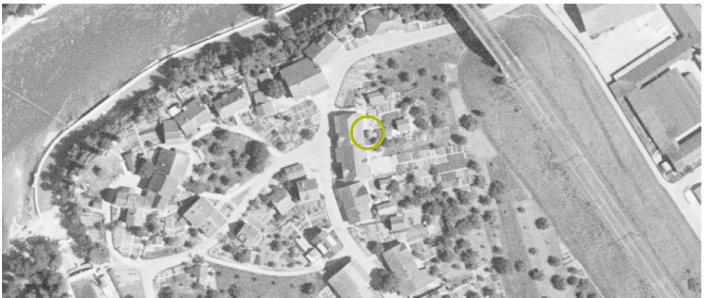
3 Brugg, Altenburg: Der Schweinestall stand am alten Standort auf der Rückseite des Hofes, in der Nähe des zugehörigen Bauernhauses. Aufnahme 1952.
