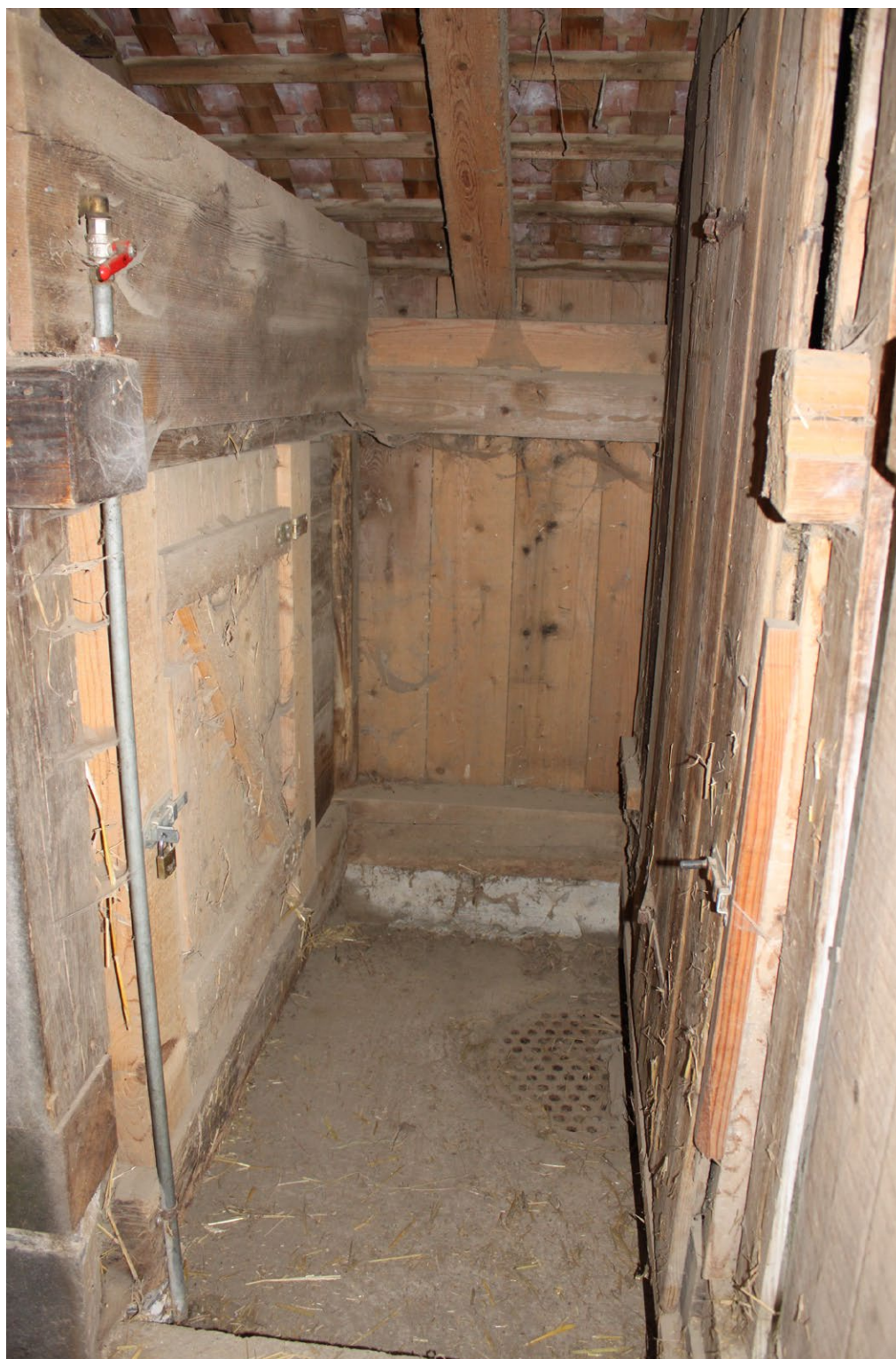
15 Freilichtmuseum der Schweiz, Schweinestall aus Altenburg/Brugg: Detail der Dachkonstruktion. Die Rafen sind an die Firstpfette gehängt. Aufnahme 2022.
