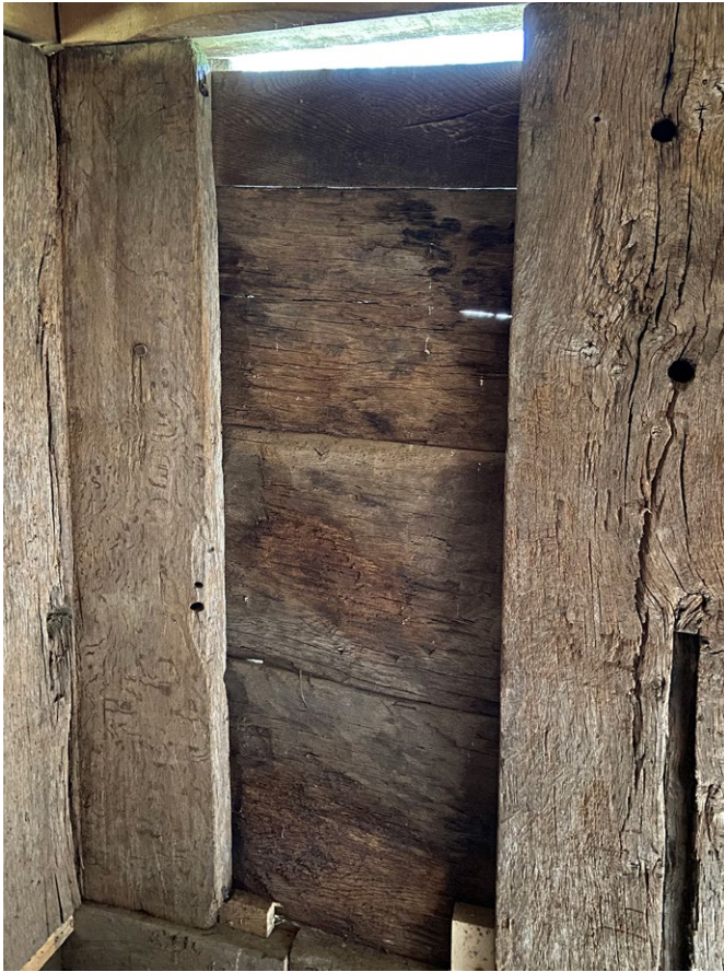
15 Freilichtmuseum der Schweiz, Kornspeicher aus Ecoteaux, La Combe: Innenaufnahme des Kornspeichers. Rechts im Bild ist der genutete Ständer zu sehen. Blick nach Südosten. Aufnahme 2022.
