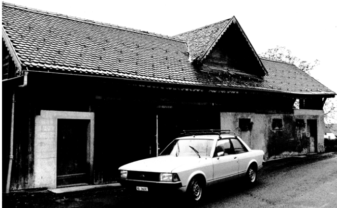
8 Ecoteaux, La Combe: Der obere Teil des Speichers war wohl seit den 1860er Jahren als Lukarne auf dem Schweinestall des Hofes aufgebaut und wurde vermutlich als Taubenschlag genutzt. Aufnahme 1985.
