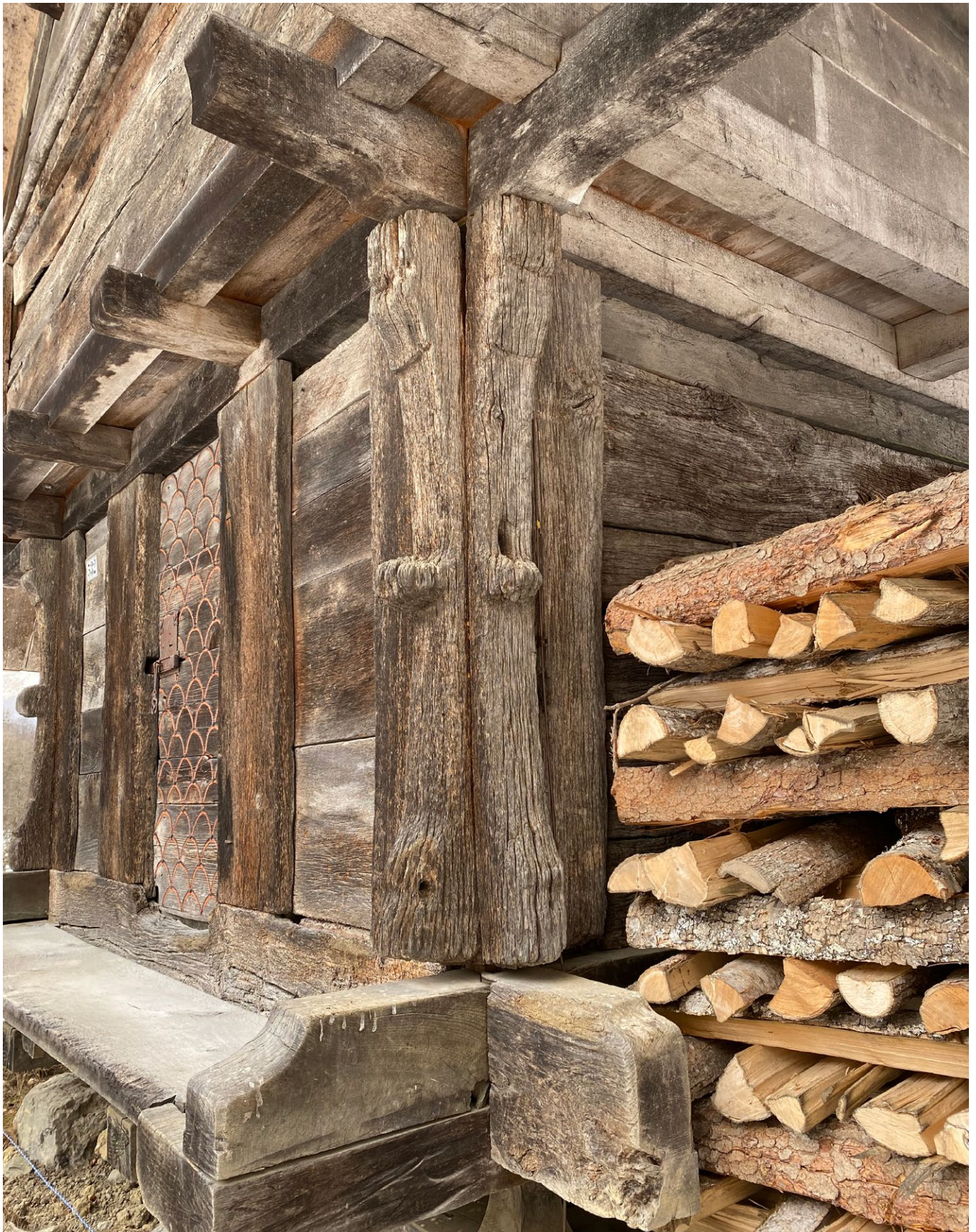
19 Freilichtmuseum der Schweiz, Kornspeicher aus Ecoteaux, La Combe: Ausschnitt der Schau- und Zugangsfassade, die einst zum Bauernhaus auf der gegenüberliegenden Strassenseite gerichtet war. Die Eckpartien sind in spätmittelalterlicher Manier profiliert. Blick nach Westen. Aufnahme 2021.
