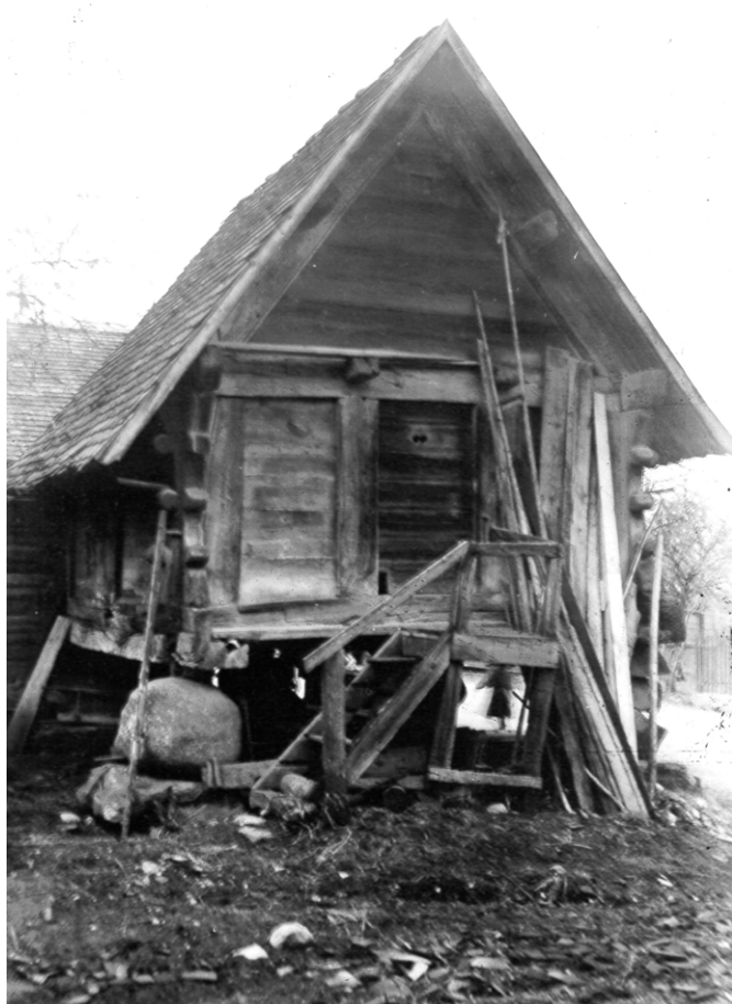
17 Boulens VD: Vergleichsbeispiel für einen typischen Vertreter der spätmittelalterlichen Kornspeicher des Gros-de-Vaud mit ähnlichen Zierelementen, erbaut um 1470. Aufnahme 1933.
