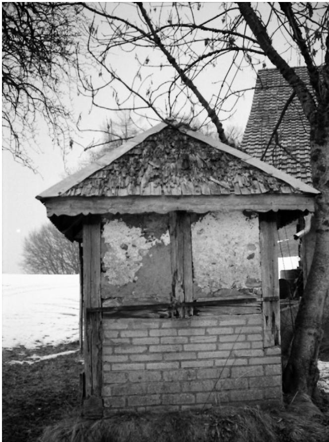
5 Wimmis, Pintelmatte: Der schlechte Zustand des Brunnenhäuschens offenbarte sich im morschen Holz, zudem blätterte teils der Putz ab. Im 20. Jahrhundert wurden Teile des Fachwerks durch Backsteinmauerwerk ersetzt. Blick nach Süden. Aufnahme um 1980.
