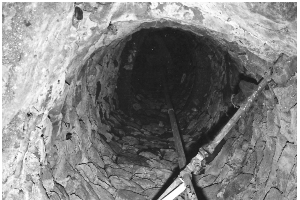
10 Wimmis, Pintelmatte: Der Schacht des ehemaligen Sodbrunnens war kreisförmig gemauert. Aufnahme um 1980.
