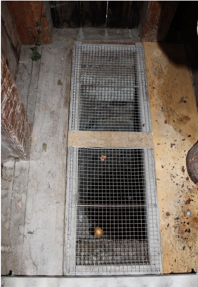
14 Freilichtmuseum der Schweiz, Sodbrunnenhäuschen aus Wimmis: Im Brunnenhäuschen dient heute ein Gitter über dem Brunnenschacht als Absturzsicherung. Aufnahme 2022.
