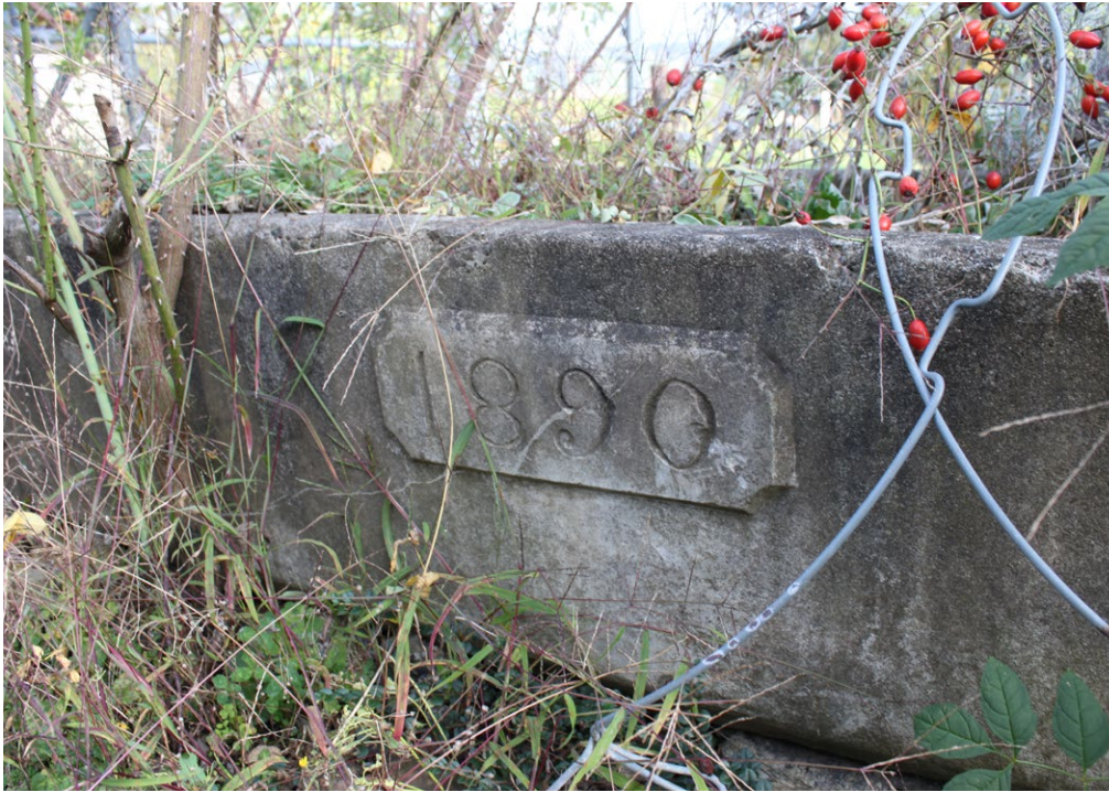
8 Wimmis, Pintelmatte: Auf der Längsseite des Troges findet sich die Jahreszahl «1890». Möglicherweise ist im selben Jahr das Brunnenhäuschen entstanden. Das Baujahr ist nicht gesichert. Aufnahme 2022.
