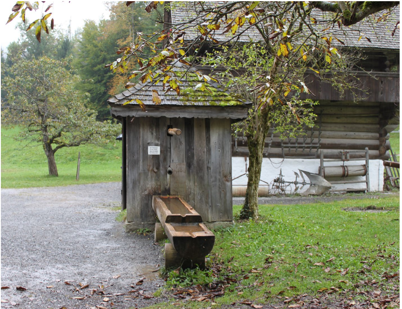
12 Freilichtmuseum der Schweiz, Sodbrunnenhäuschen aus Wimmis: Durch die Brettverschalung hat das kleine Gebäude auf dem Ballenberg ein völlig anderes Erscheinungsbild erhalten. Das frühere Sichtfachwerk wurde nicht wiederhergestellt. Blick nach Süden. Aufnahme 2022.
