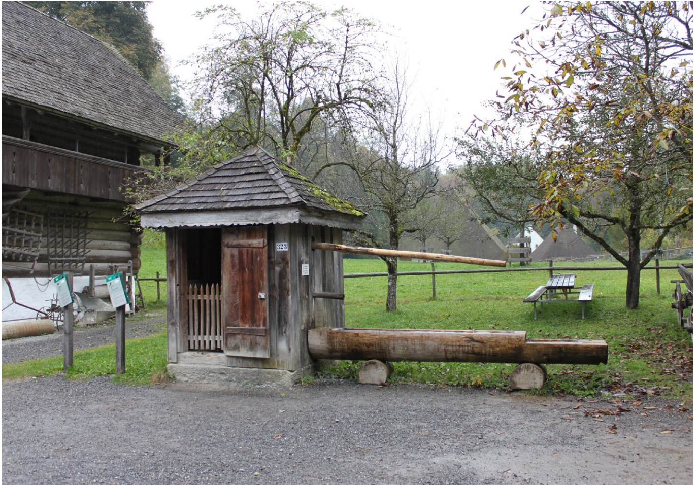
13 Freilichtmuseum der Schweiz, Sodbrunnenhäuschen aus Wimmis: Der Brunnentrog wurde durch einen Holzstamm ersetzt und anders positioniert. Blick nach Westen. Aufnahme 2022.
