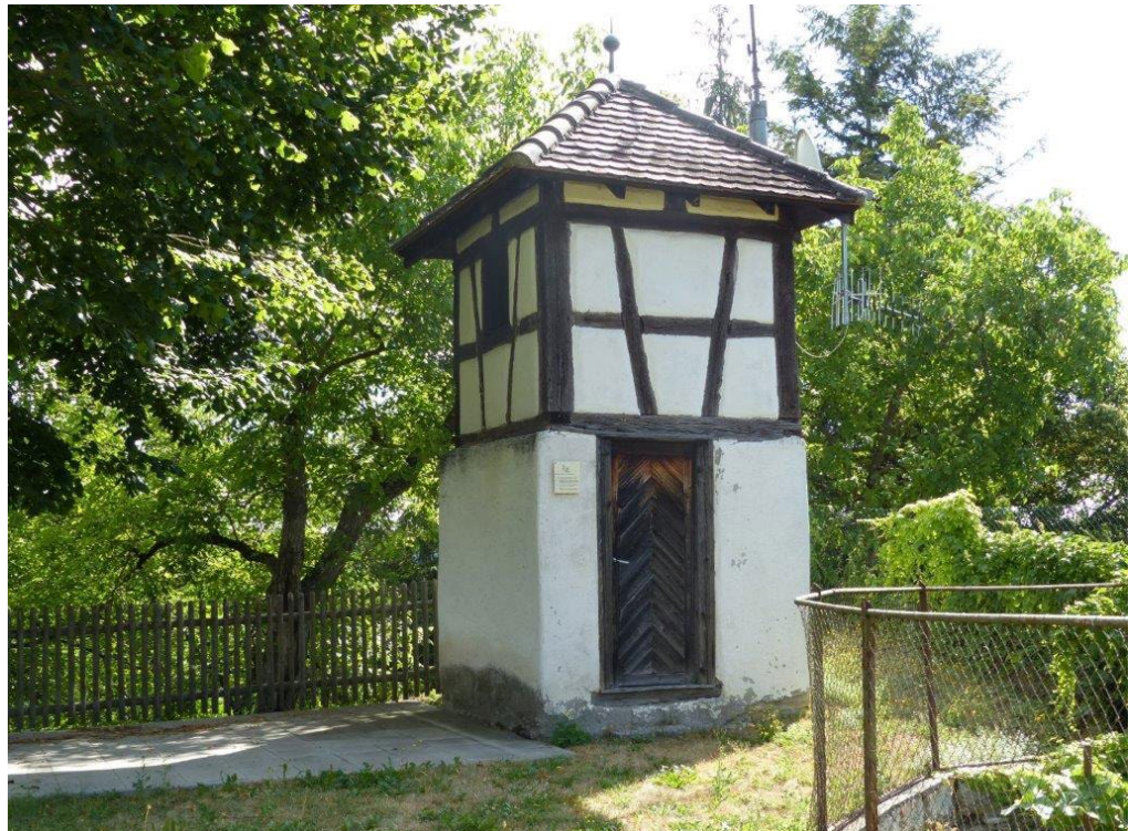
9 Baden-Württemberg, Aach: Das obere Geschoss in Fachwerkbauweise mit dem Zeltdach ähnelt dem Brunnenhäuschen aus Wimmis. Aufnahme 2016.
